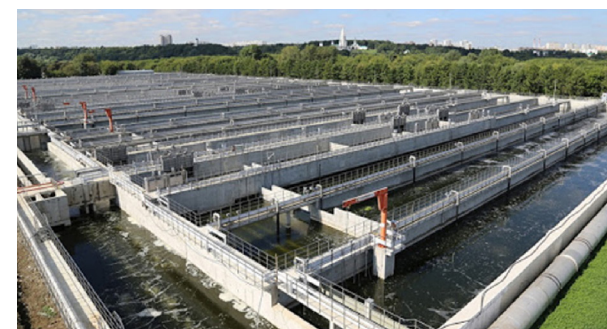
Рисунок 28 — Очистка сточных вод на очистных сооружениях
